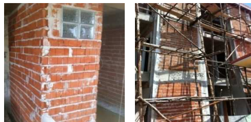
ภาพที่ 5 นำก้อนอิฐมอญซีเมนต์ผสมเถ้าแกลบไปก่อสร้างจริงเพื่อหาคุณสมบัติทางด้านวิศวกรรม
